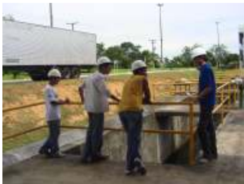
Estação de tratamento de água
